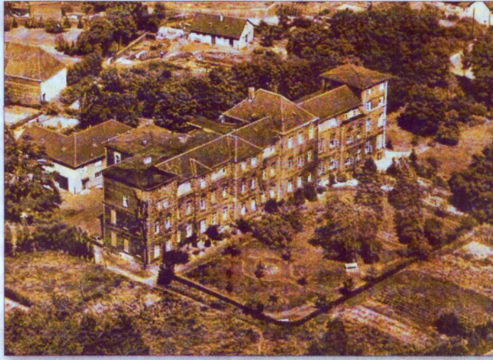
Ein Bild aus der Nachkriegszeit. Die Klinik hatte ebenfalls im Zweiten Weltkrieg gelitten, wurde aber später saniert. Fotos (2): Evangelische Stiftung Augusta
