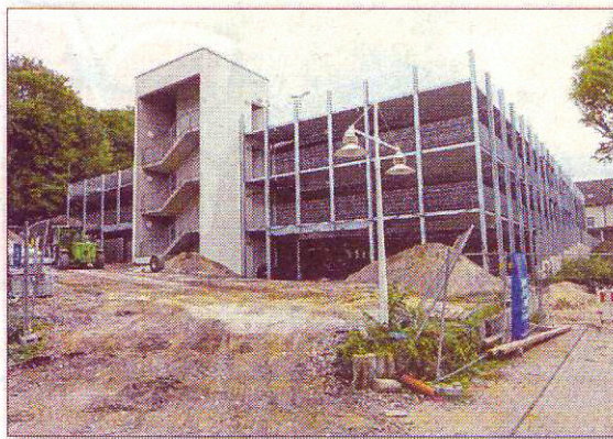
Das neue Parkhaus mit 227 Stellplätzen wird voraussichtlich noch im Oktober eröffnet. Foto: Franken
