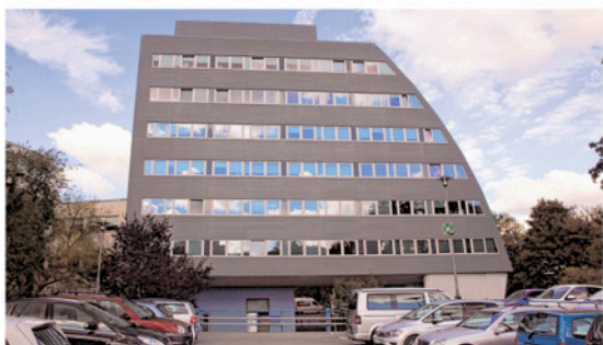
Das EvK an der Breidenscheider Straße wurde 1967 erweitert – das bedeutete auch mehr Platz für die Patienten.
