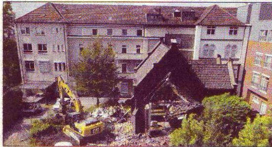
Der Abriss ist in vollem Gange. Foto: Stiftung Augusta
