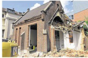
Die Kapelle nach den ersten Eingriffen des Abrissbaggers. FOTO: AUGUSTA-KLINIK
