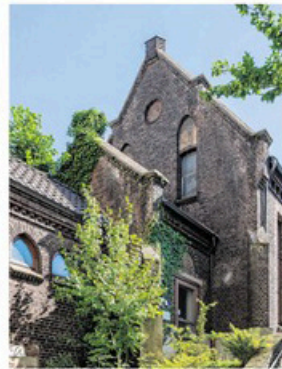
Der Bau aus rotem Backstein versprüht historischen Charme.
