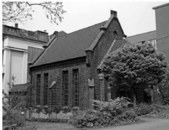
Steht vor dem Abriss: die alte Kapelle der Augusta-Klinik.
