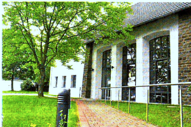
Die alte Kapelle am Augusta-Krankenhaus erstrahlt in neuem Glanz.
