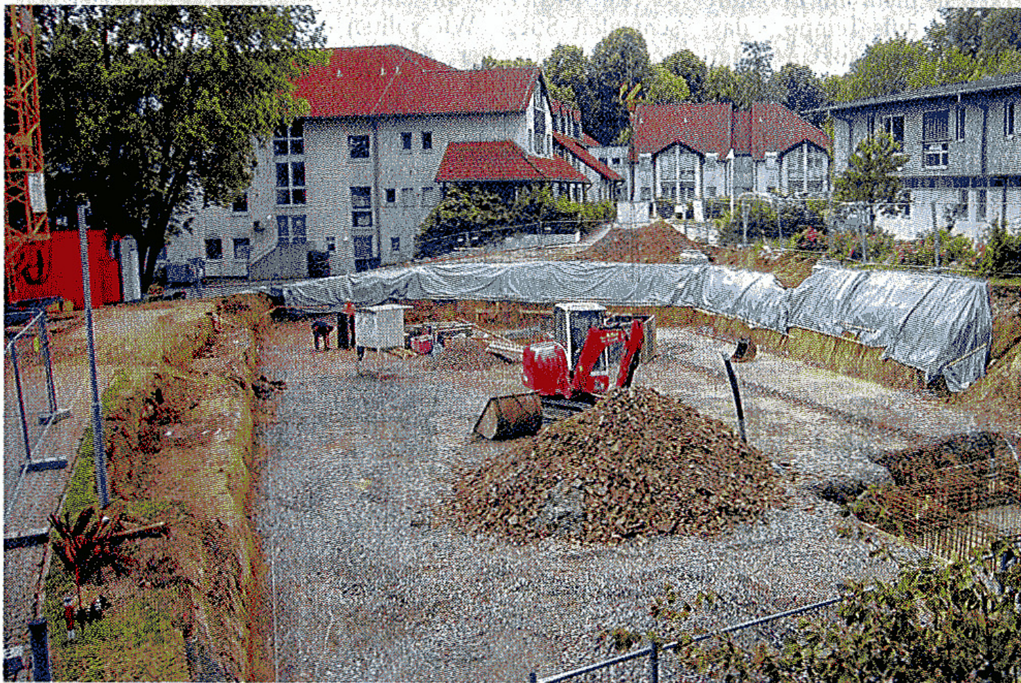
Der Bagger rollt an der Bredenscheider Straße: Das EvK wird erweitert.
