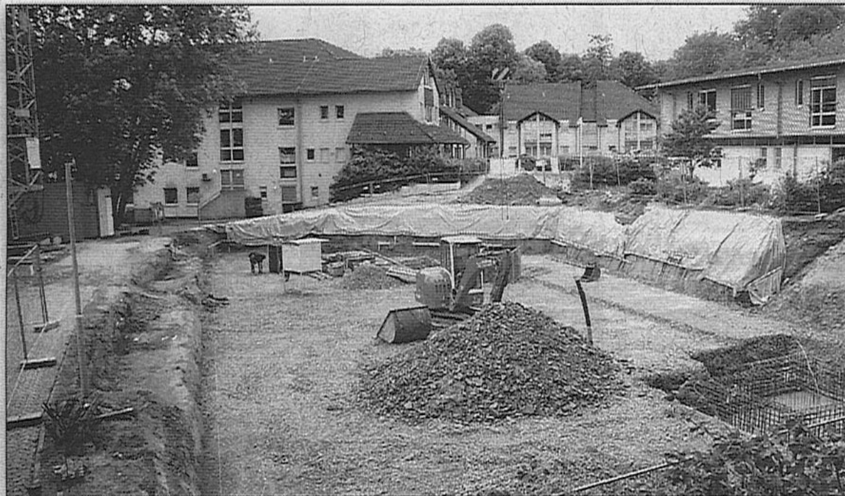
Eine große Baustelle gibt es zur Zeit auf dem Gelände des Evangelischen Krankenhauses an der Bredenscheider Straße Foto: EvK/Franken
